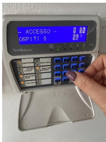
Fig. 5 e 6 – tastierino impianto antintrusione
