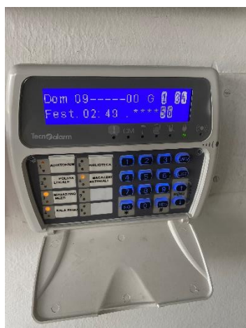
Fig. 5 e 6 – tastierino impianto antintrusione
