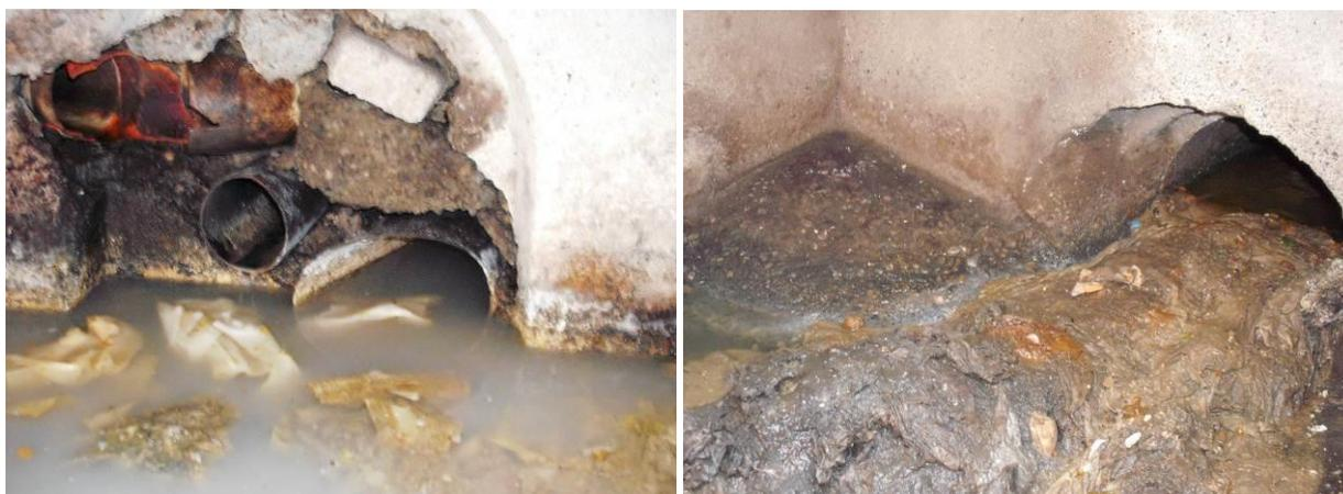
**Figura 42 - Pozzetti di ispezione relativi al nodo 356 a sinistra e 355 a destra dove è possibile rilevare una notevole quantità di materiale depositato**
