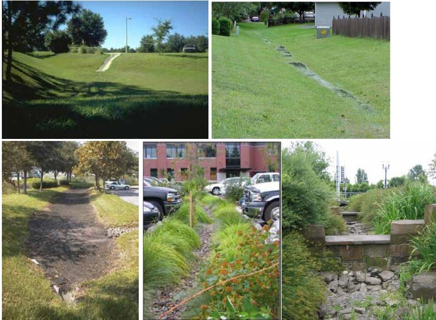
Figura 20 – Esempi di strutture di laminazione fuori terra delle acque dei tetti, strutturabili sia per la sola laminazione sia per il riuso
